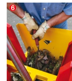
Liage du lien en fil de fer à l'aide d'une pince (torsadeur).
