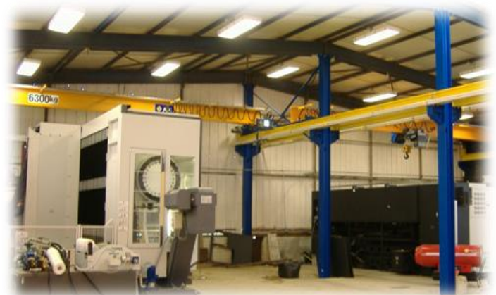
Installation de pont roulant
